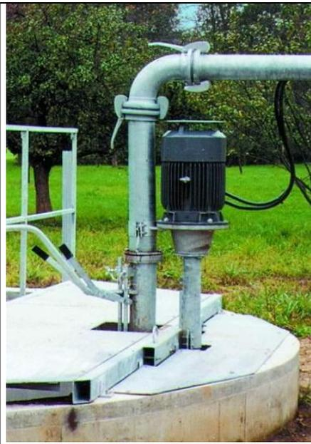
Die Pumpe wird bis auf den Grund der Grube abgesetzt, senkrecht eingerichtet und mit einer Schelle um die Antriebswelle an den Querträger befestigt. Der Träger und allenfalls eine Arbeitsbühne ist an der Grube / Behälter befestigt
